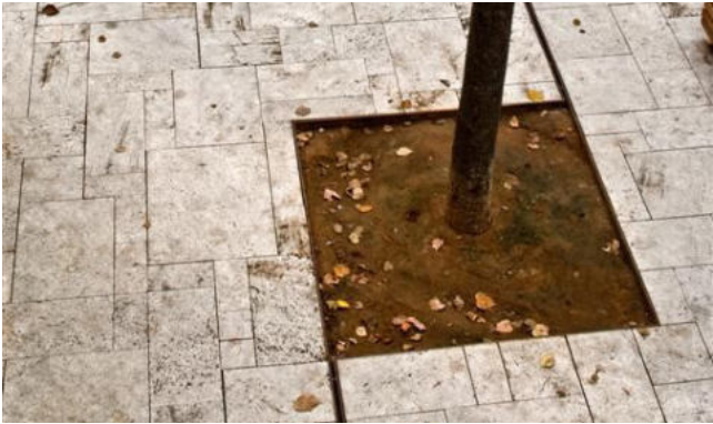
detail umístění stromu ocelovým obrubníkem
