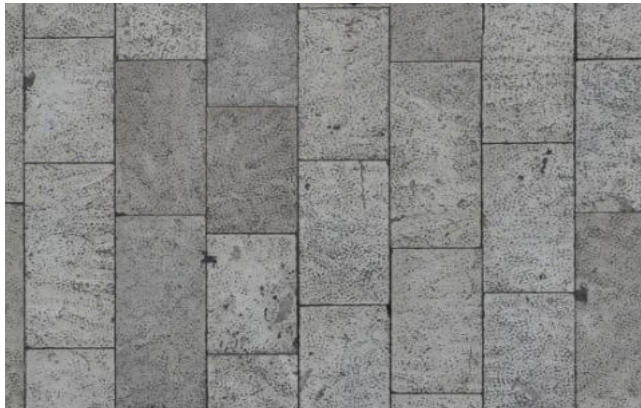
hlavní komunikace v rámci návsi v betonové dlažbě
