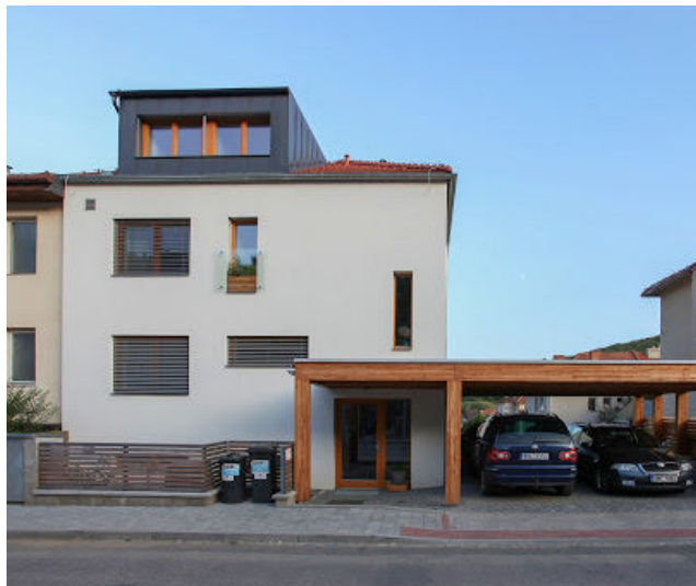
komunikace domu s ulicí - Brno, David Zajiček
