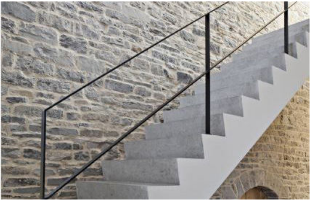
příklad minimalistického zábradlí
