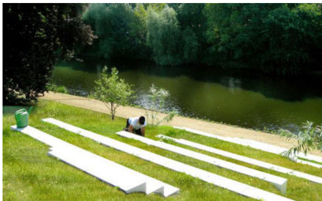
pobytové schody ve svahu
