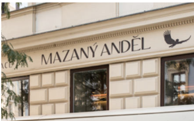
ukázka malovaného nápisu v souladu s prvky fasády
