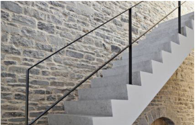
příklad minimalistického zábradlí
