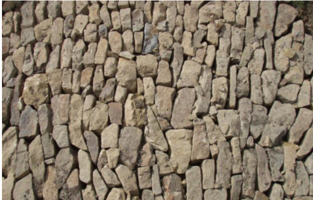
štetová dlažba - nutné pohodlné pochozí provedení
