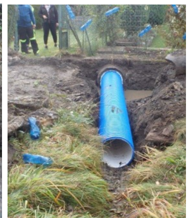
Oprava potrubí u zahrádek
