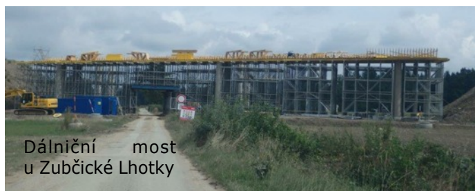
Stavba nadjezdu před otevřením
