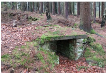
Úkryt dělníků v lomu při odstřelu Chlumská hora
