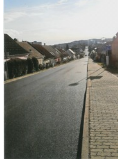
Asfalt v ulici V Domkách 2019
