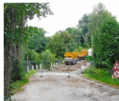
Oprava mostu červenec 2011
