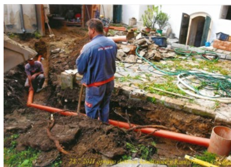
Oprava dešťové kanalizace na Kantůrkovci červenec 2011
