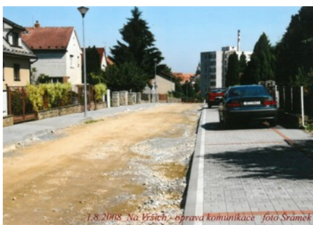
Oprava komunikace Na Vrších srpen 2008
