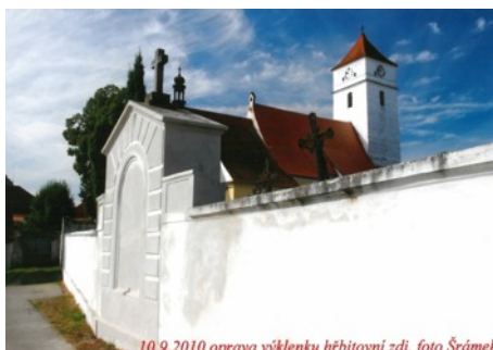
Oprava výklenku hřbitovní zdi září 2010
