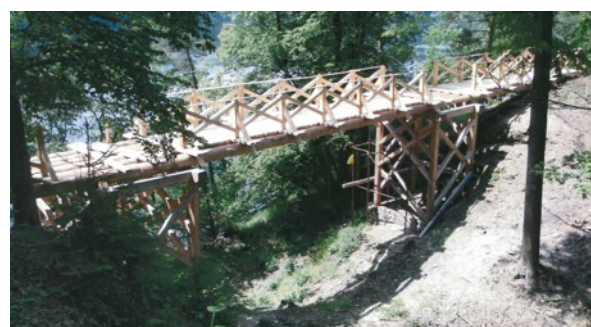
Stavba mostu na hradě 2012
