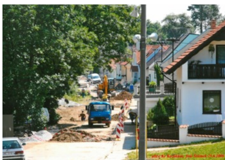
Rekonstrukce ulice Ke Kozákům červen 2006
