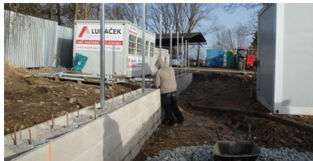
Stavební úpravy sběrného dvora, opěrná zeď a nové oplocení
