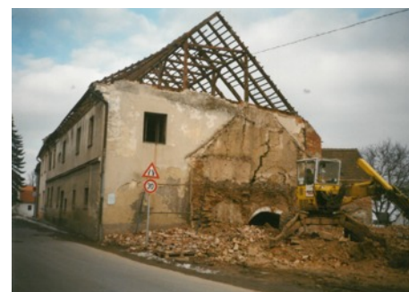
Demolice domu č.65 Kamarýtovec - únor 2001
