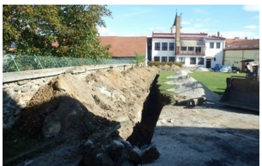
Připojení teplovodu z kina do Podkovy říjen 2020
