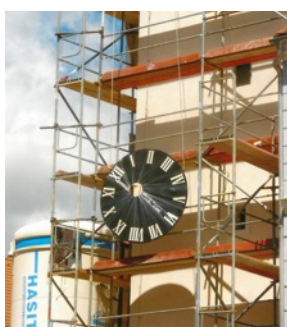
Oprava ciferníku věžních hodin kostel sv. Filipa a Jakuba 2011
