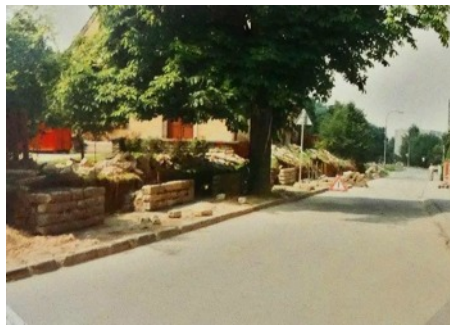
Stavba nové zdi u mateřské školky srpen - 1996
