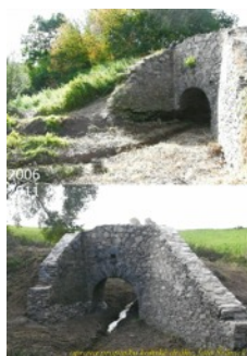
Oprava můstků koňské dráhy 2011
