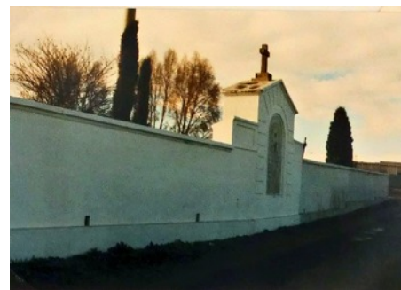
Oprava hřbitovní zdi - 12.11.1997
