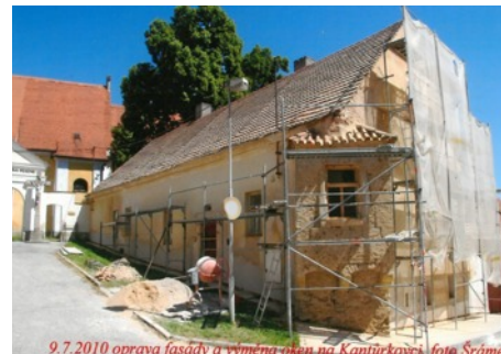
Oprava fasády a výměna oken na Kantůrkovci - červenec 2010
