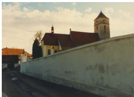
Hřbitovní zeď před opravou 1997
