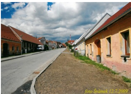
Zatrubnění stoky v ulici V Domkách - červenec 2009
