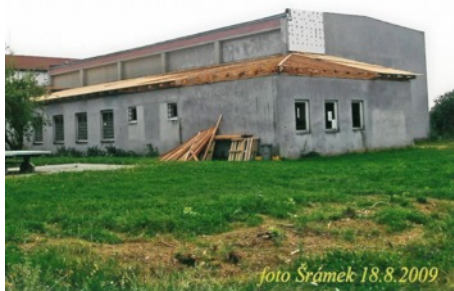
Oprava tělocvičny ZŠ - srpen 2009
