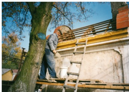
Oprava kapličky ve Skřidlech 2000
