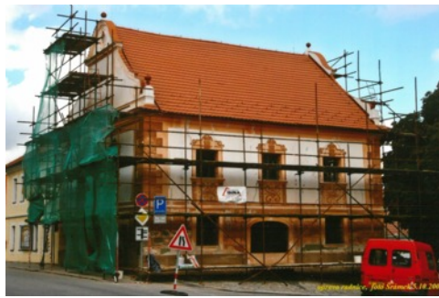
Oprava radnice říjen 2006
