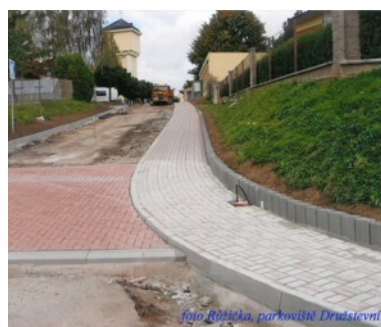
Rekonstrukce ulice Družstevní září 2012
