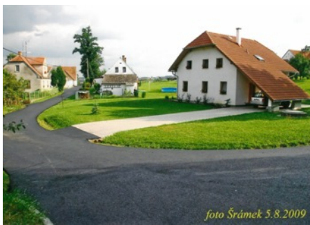
Oprava komunikace v Chodči srpen 2009
