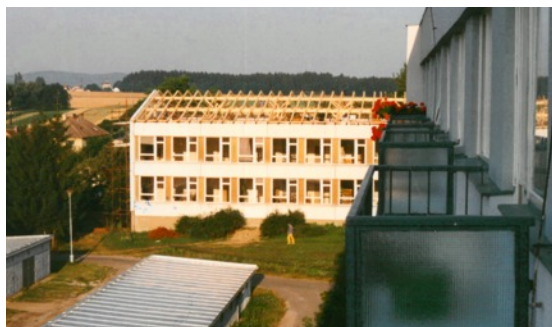
Zastřešení pavilonu učeben ZŠ 1999
