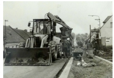
Budování chodníků a osvětlení V Domkách 1997
