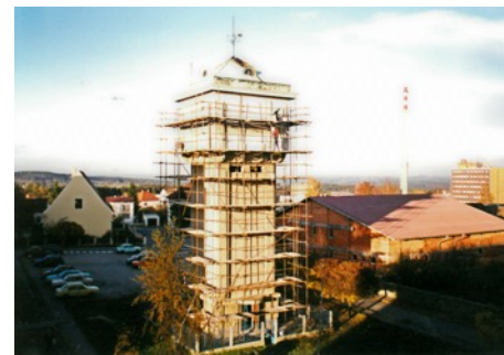
Vodárenská věž - oprava fasády a nová střecha listopad 2000
