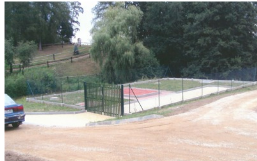
ČOV a kanalizace Chodeč 31.7.2003
