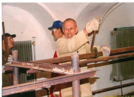
Brigáda při rekonstrukci bývalého pivovaru 19.8.2005
