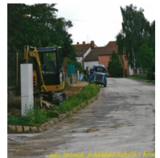
Rekonstrukce ulice Krumlovská 7.9.2007
