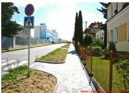
Rekonstrukce ulice Budějovická srpen 2006
