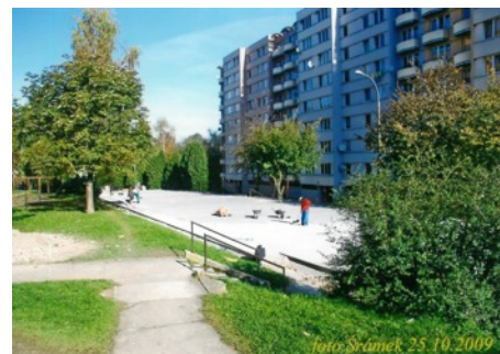
Budování parkovišť na Sídlišti - říjen 2009
