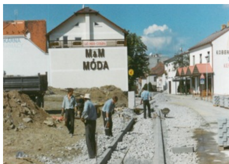
Pokládka kabelů a nový chodník v ulici Školní 13.8-4.9.1998
