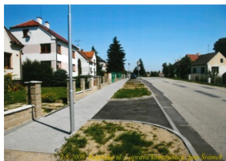
Oprava komunikace Kaplická srpen 2008
