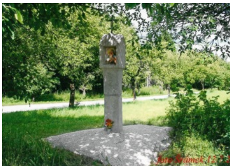
Oprava kamenného sloupu - cesta na Svatý Jan nad Malší - červenec 2009
