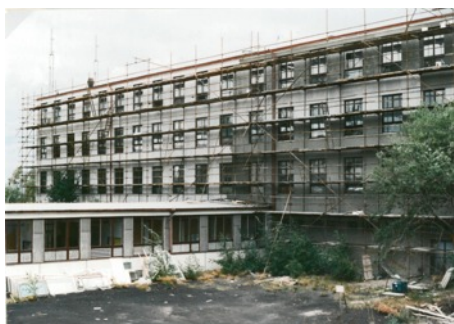
Zateplení západní stěny hl.budovy ZŠ - 1.7.-7.8.1998
