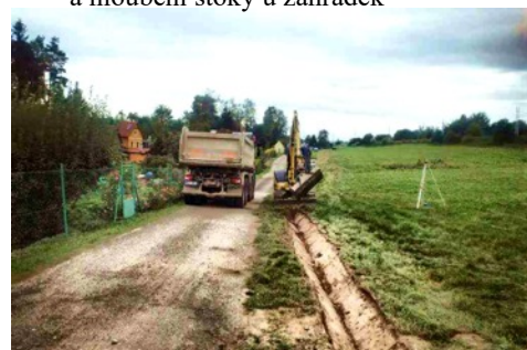
Oprava potrubí v Dolní ulici a hloubení stoky u zahrádek
