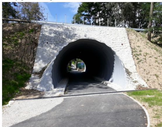
Nový podchod pod E55 k vlakové zastávce
