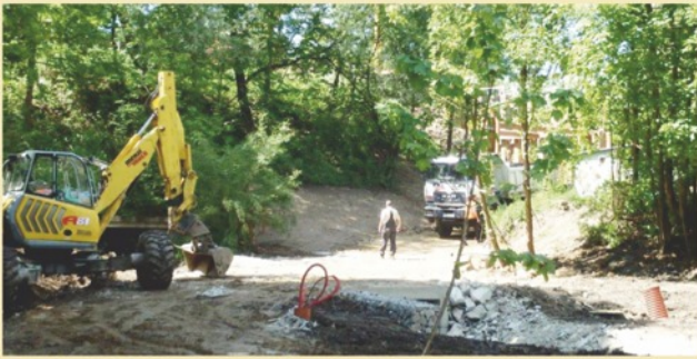
Stavba podchodu pod E55 - přístupová cesta od Penny Cesta z podchodu směrem k zastávce ČD. U cest bude instalováno veřejného osvětlení.
