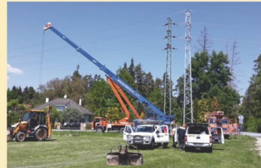
Nádraží - výměna poškozeného stožáru VN
