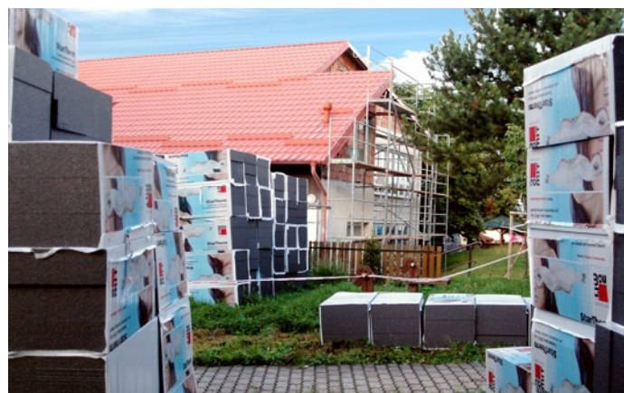
Stavební práce - mateřská škola
