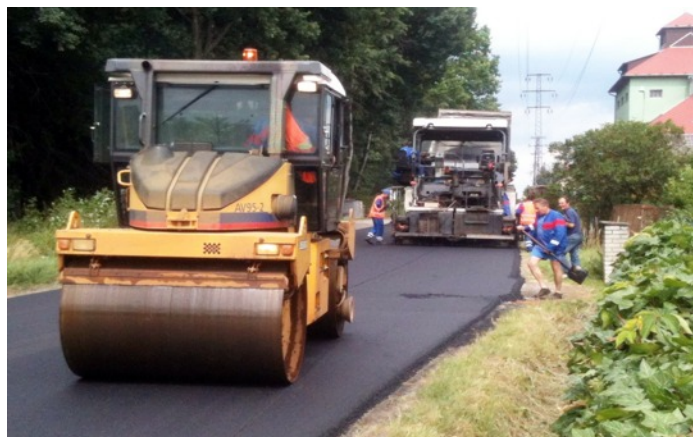
Modernizace silnice III/15710 Mirkovice - Velešín (Správa a údržba silnic Jihočeského kraje). Na foto dokončování povrchu v lokalitě Velešín - Nádraží
