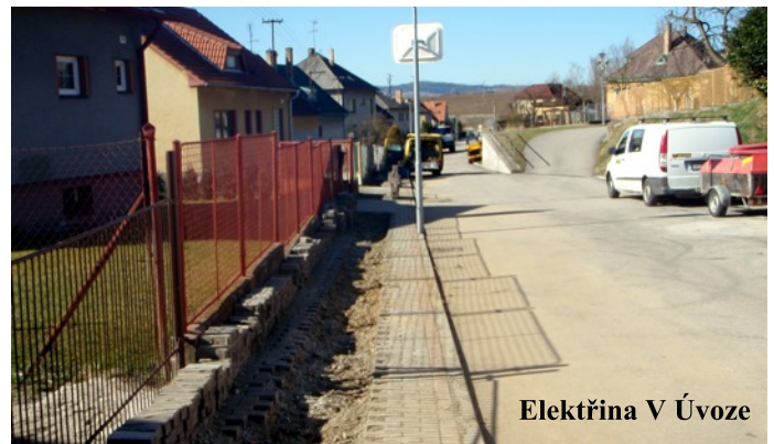
Příprava na opravu kašny a jejího okolí
