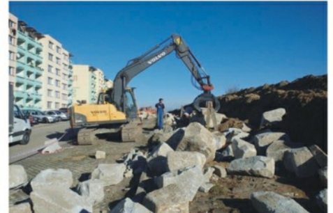
Revitalizace sídliště Nad Cihelnou
